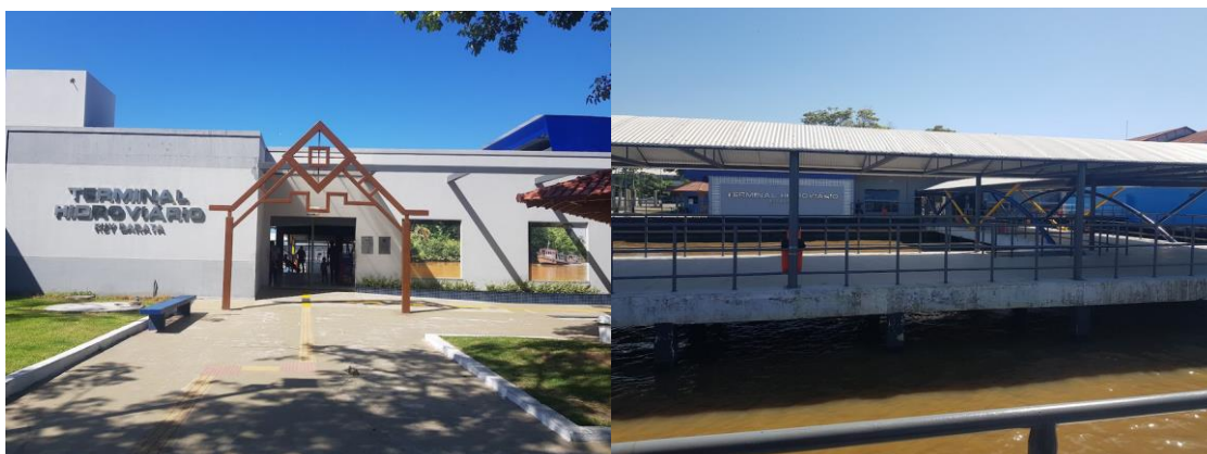
Figura 10- Porto de embarque da Praça Princesa Isabel - Terminal Hidroviário Ruy Barata
