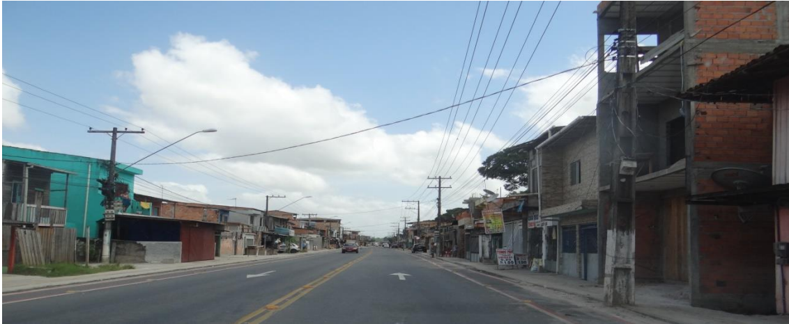
Figura 1 - Avenida Perimetral. Bairro da Terra Firme - 2017.
