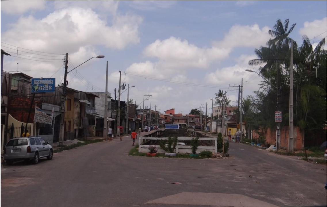
Figura 7 – Canal da Avenida Cipriano Santos. Bairro da Terra Firme - 2017.
