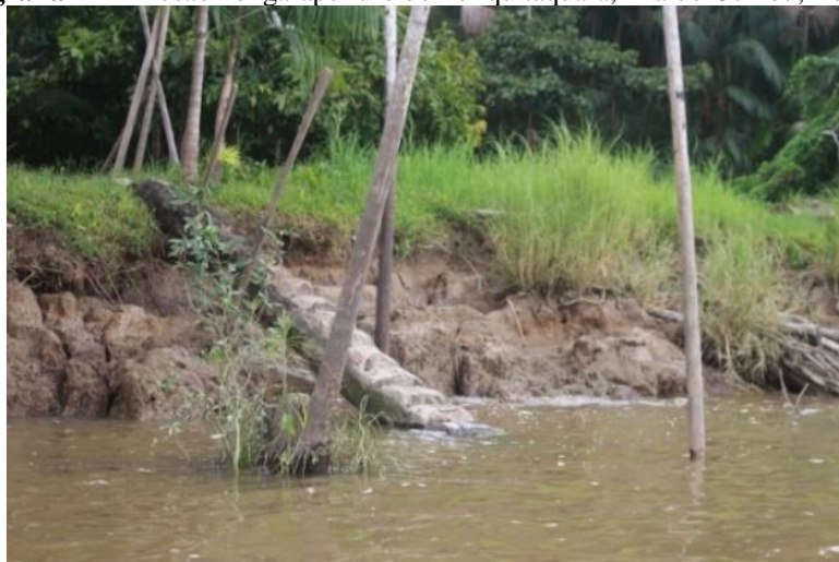
Fotografia 21 – Erosão no igarapé furo do Periquitaquara, ilha do Combu, Belém, Pará.
