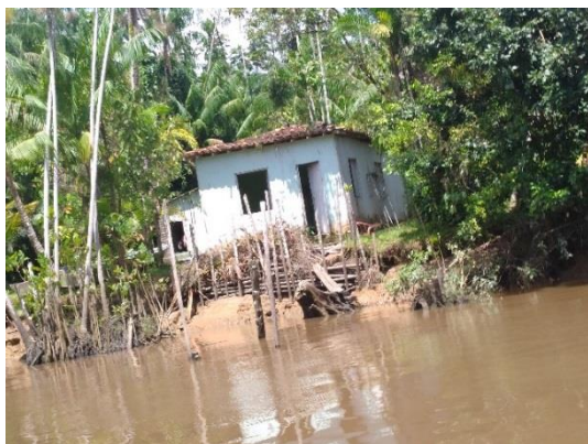
Fotografia 22 – Proteção de madeira e de galhos para conter a erosão nos terrenos, ilha do Maracujá e do Murutucu, Belém, Pará.
