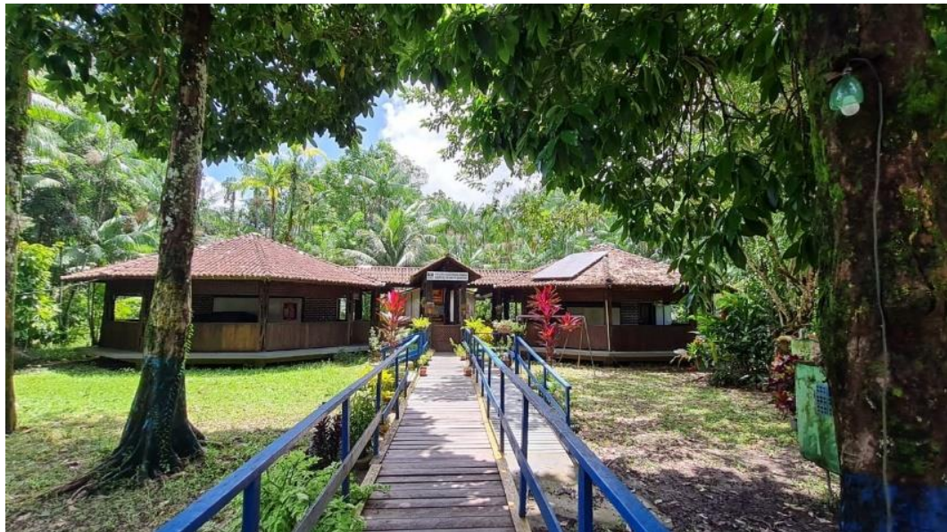
Fotografia 2 – Escola Santo Antônio, localizada na Comunidade Igarapé Periquitaquara, ilha do Combu, Belém, Pará.
