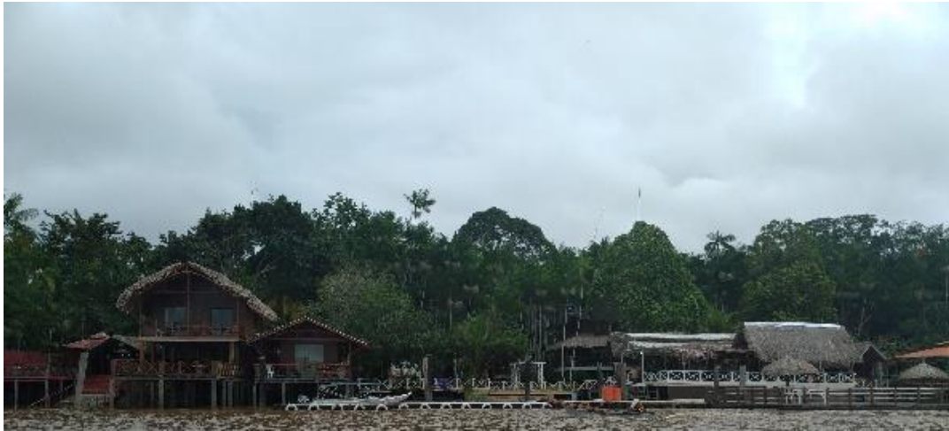
Fotografia 4 – Restaurante ilha Branca e chalés, ilha do Murutucu, Belém, Pará.
