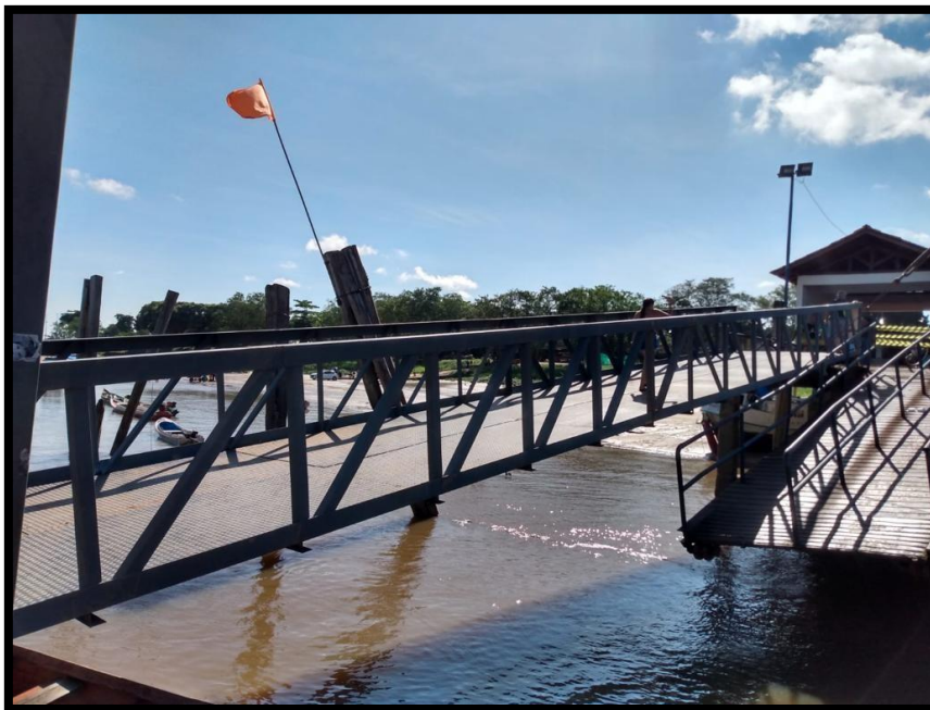
Figura 40: Ponte de embarque e desembarque, antes da reforma
