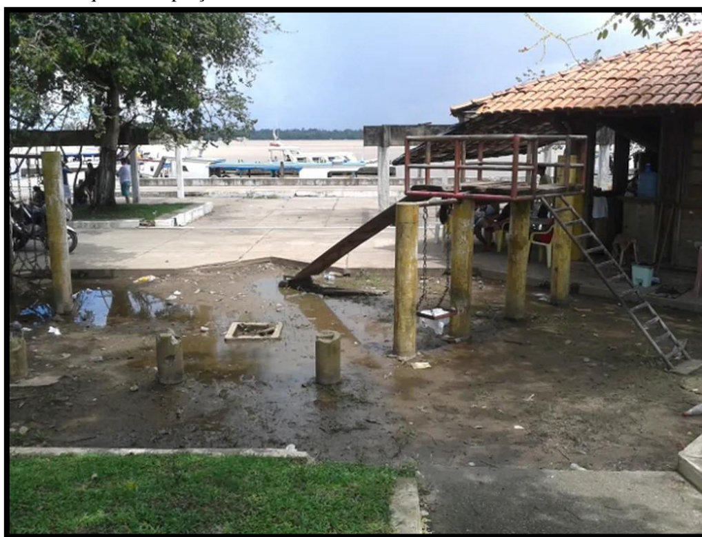
Figura 54: Parquinho na praça Princesa Isabel, antes da reforma
