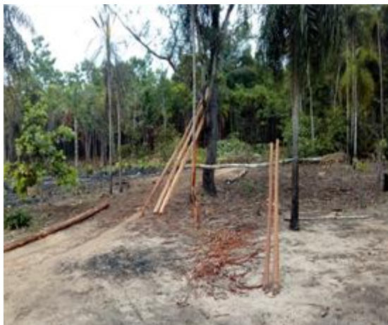
Figura 94- Casa em Construção.
