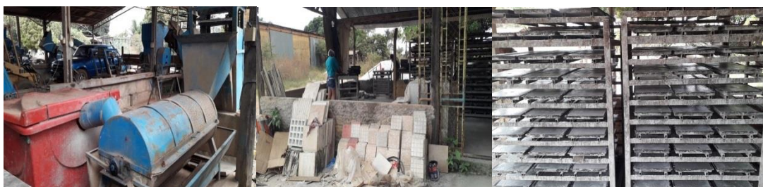
Figura 9 - Pisos (pavers) feitos com agregado de RCC.
