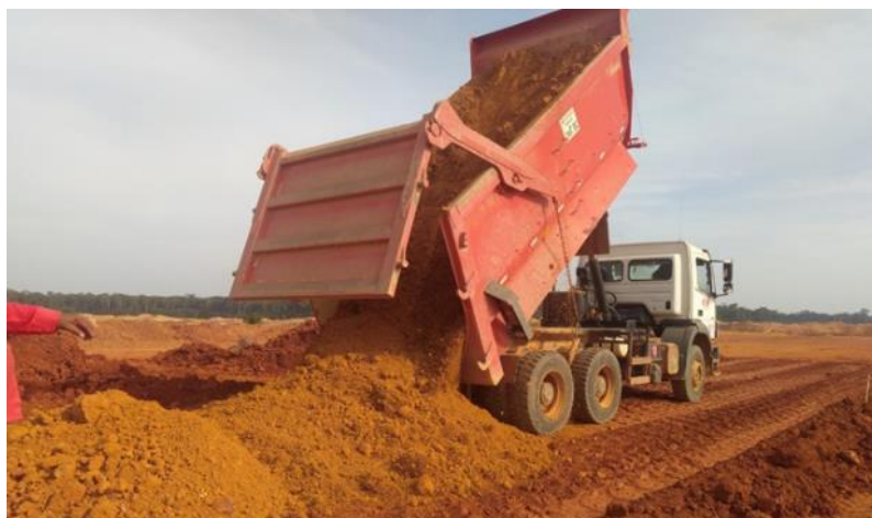
Figura 5.8 - Lançamento dos materiais.
