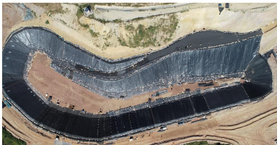
Figura 4.3 - Aterro industrial para disposição de material contaminado.
