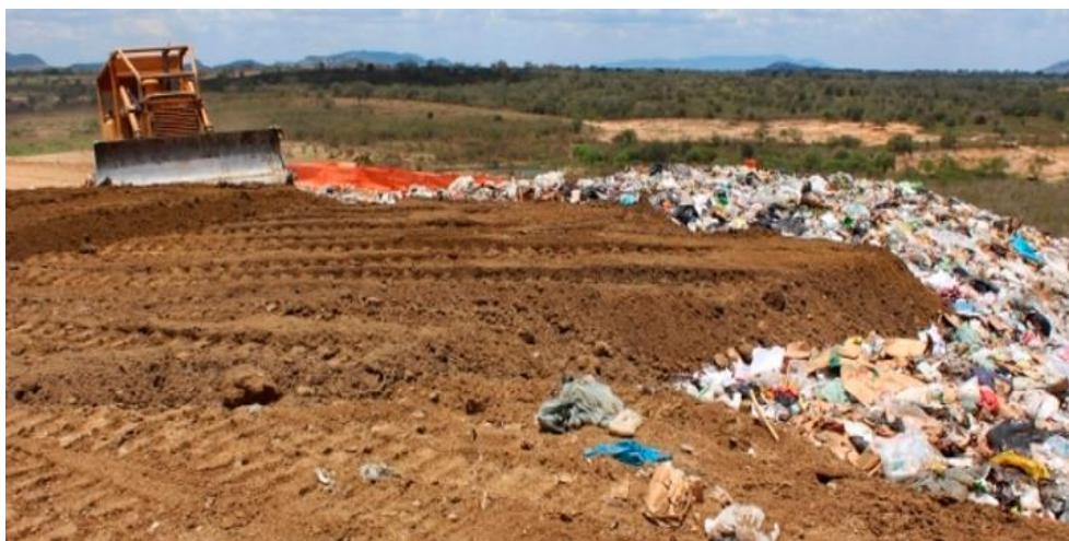
Figura 4.4 - Aterro sanitário para disposição de lixo urbano.
