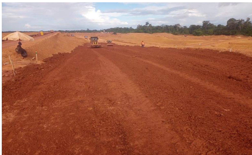
Figura 4.5 - Aterro em obras de terraplenagem.
