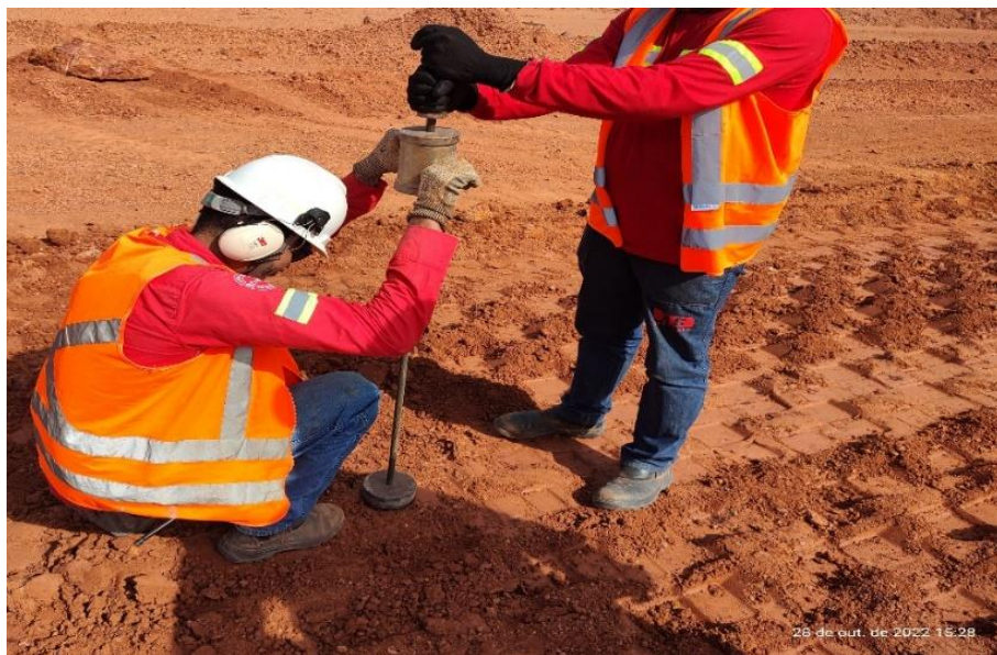
Figura 5.10 - Ensaio de compactação da camada de aterro.
