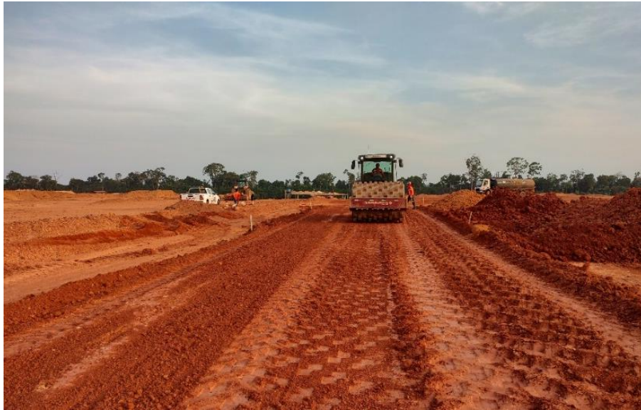
Figura 5.9 - Compactação da mistura de 50% de Rejeito / 50% de argila.
