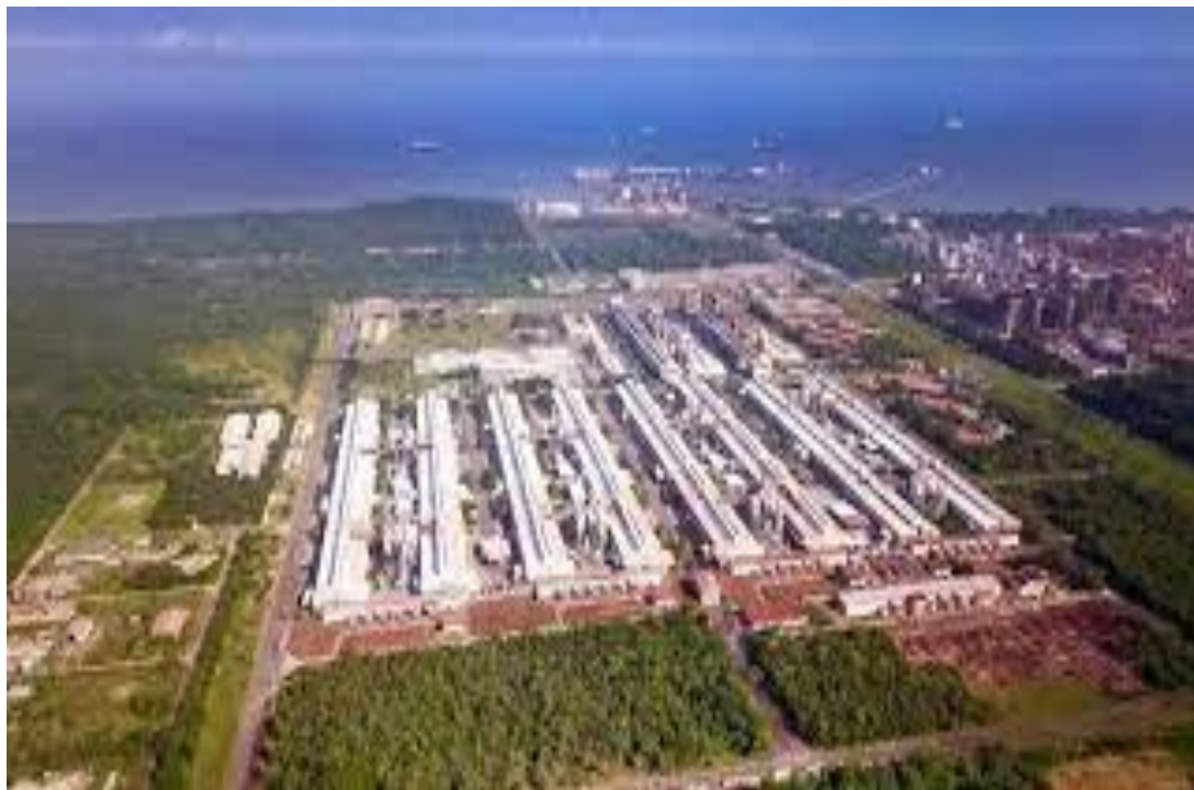
Imagem 6: Vista Aérea da Albras Alunorte no município de Barcarena.
