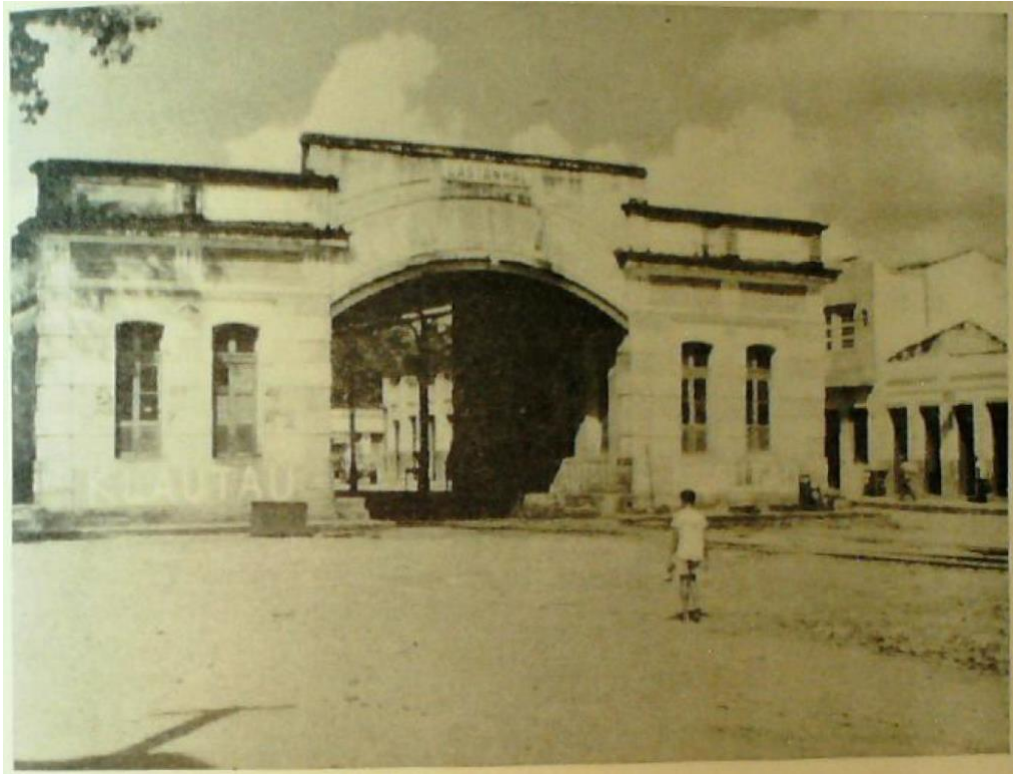
Figura 2 - Estação Ferroviária de Castanhal
