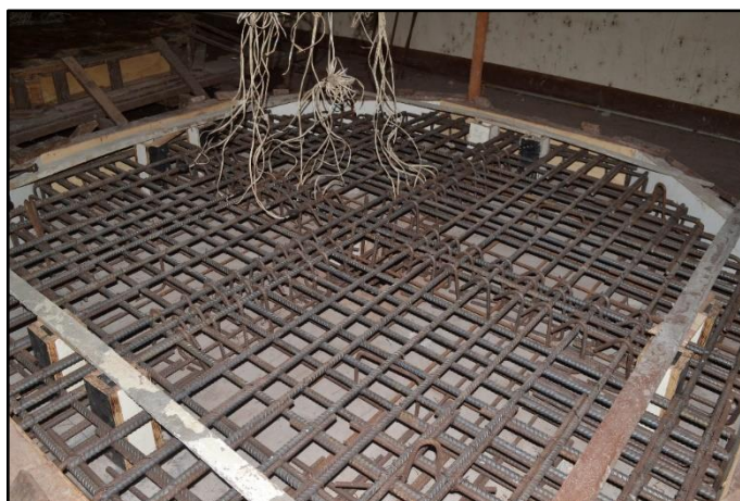
Figura 3.5 – Laje com estribos (Autora, 2023).
