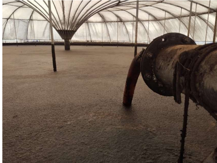
Figura 14 - Piscina de efluente
