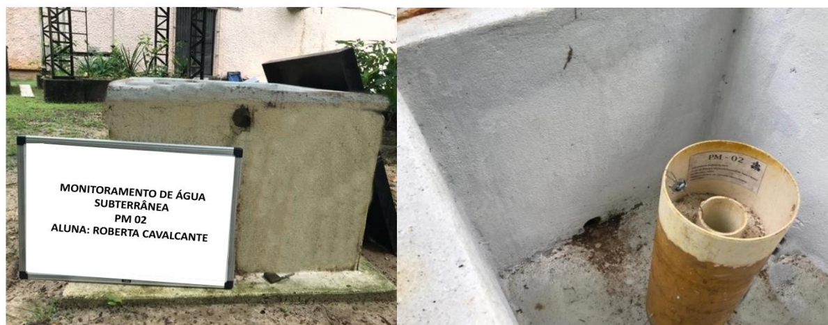
Figura 16- Poço de Monitoramento 02 (PM-02).
