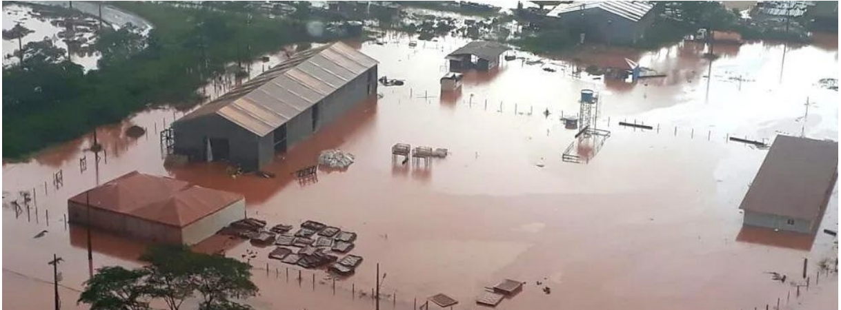
Figura 7- Vista de aérea do Distrito Industrial, submersa em alagamentos de coloração avermelhada, a partir de vazamento de rejeitos de mineração
