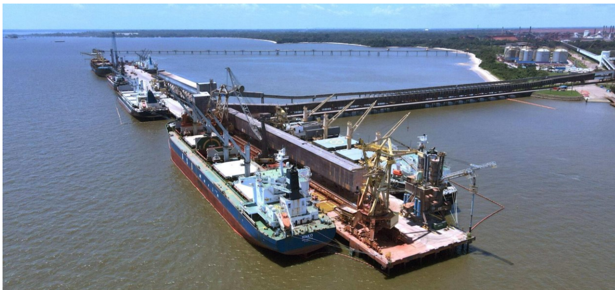
Figura 12 - Porto de Vila do Conde, em Barcarena, após a ampliação
