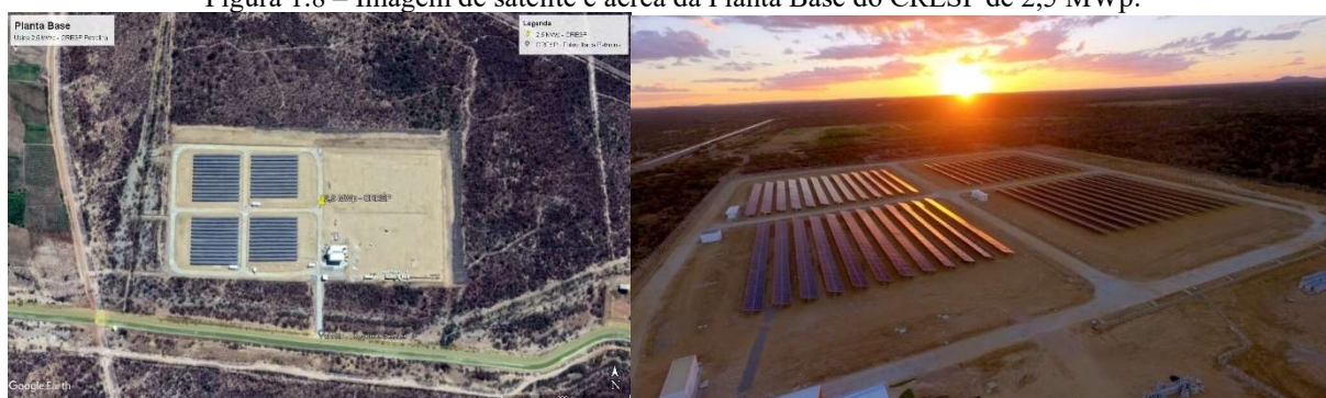
Figura 1.8 – Imagem de satélite e aérea da Planta Base do CRESP de 2,5 MWp.
