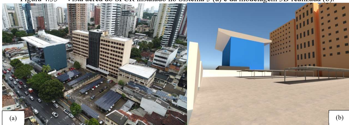
Figura 4.33 – Vista aérea do SFCR instalado no Sistema 5 (a) e da modelagem 3D realizada (b).
