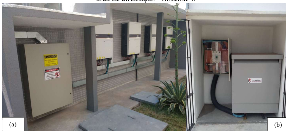
Figura 3.18 – (a) Localização dos inversores, (b) autotransformador para conexão à rede. Ambiente Externo: área de circulação - Sistema 4.
