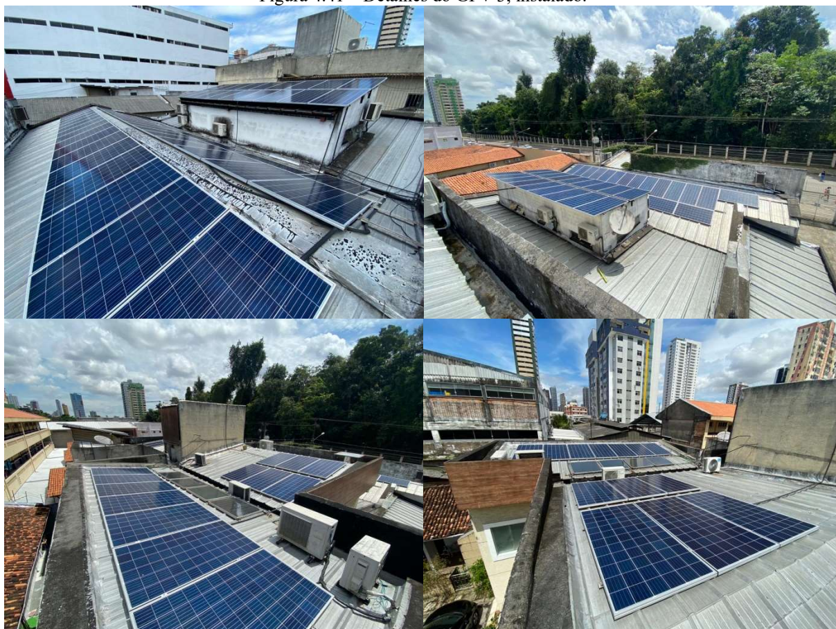
Figura 4.41 – Detalhes do GFV 3, instalado.
