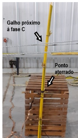
Figura 25. Teste com galho de bambu de 0,5 metro em contato com o condutor.
