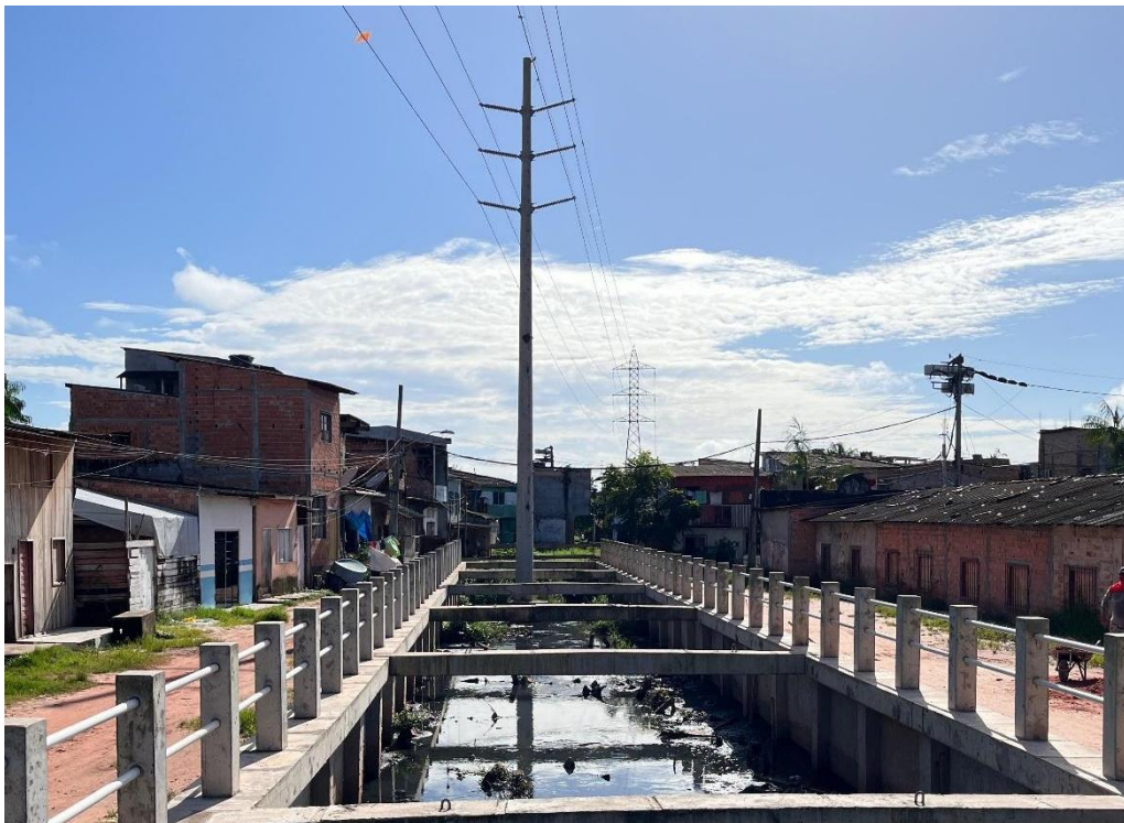
Figura 26. Galeria de macrodrenagem do Lago Verde, com poste ao fundo
