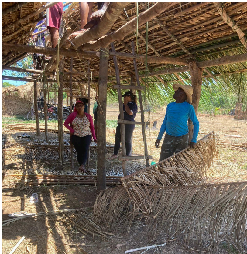
FIGURA 10: Construção de Barracões na comunidade de Salvá
