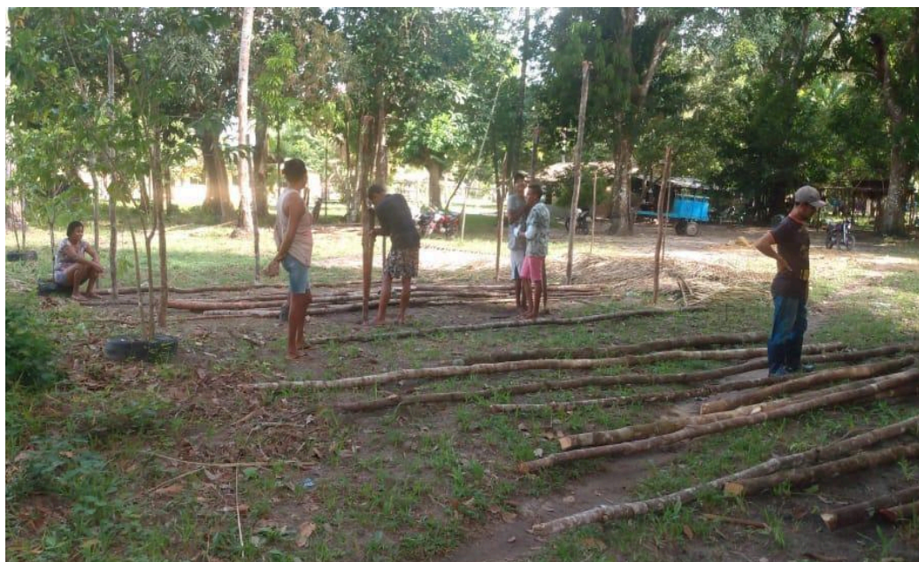
FIGURA 9: Estruturando barracão comunidade de Paixão
