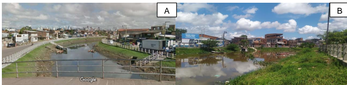
Figura 11 - Etapa 1 - Trecho 2 da Obra de Macro drenagem do Tucunduba A) Imagem do Google Maps de Abril de 2020; B) Fotografia Maio de 2021.
