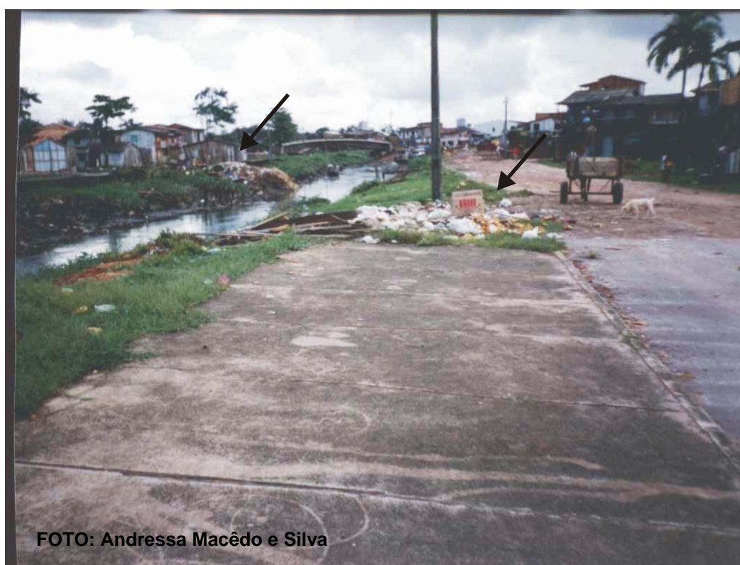
FIGURA 25 – Igarapé Tucunduba: entulhos no seu leito e talude; carência de lixeiras públicas causando acúmulo de lixo nas ruas. Parte da margem do igarapé urbanizada (2003).
