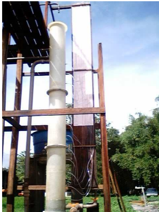
Fotografia 31 - Piezômetros do filtro rápido descendente. Fonte: Direta.
