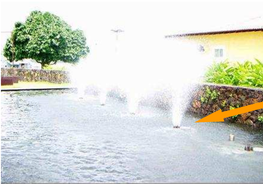
Fotografia 5 - Aerador do tipo Repuxo Fonte: Lopes(2005)
