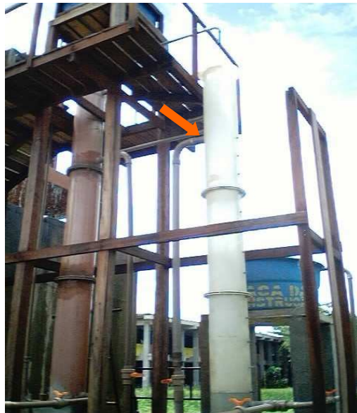
Fotografia 32 - Extravasor do Filtro Rápido Descendente
