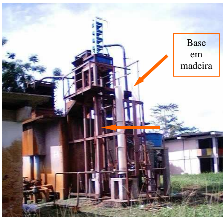
Fotografia 19 - Estrutura de madeira do Aerador da ETA-Piloto. Fonte: Direta
