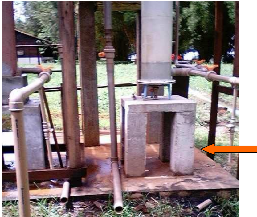
Fotografia 21 - Base de concreto para apoio do filtro da ETA-Piloto. Fonte: Direta.
