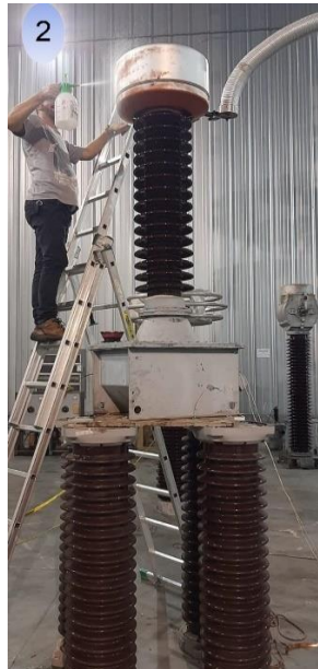
Figura 10: Registro no ensaio do TPI de 145 kV.
