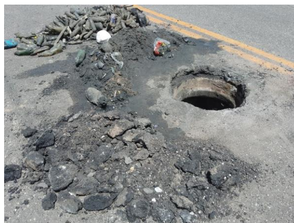
Figura 23 – Desobstrução de galeria pelo serviço de limpeza pública
