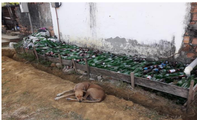
Figura 09 – Reutilização de garrafas de vidro na construção de calçadas na Vila de Algodal
