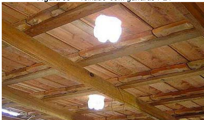
Figura 08 – Telhado com garrafas PET
