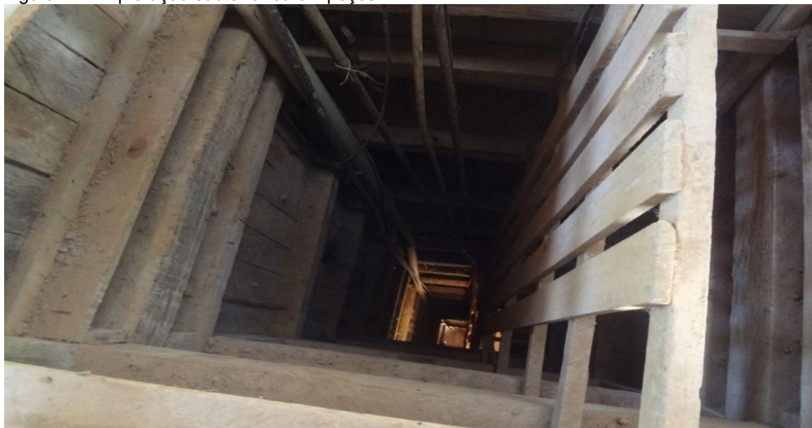
Figura 21 - Exploração subterrânea em poços
