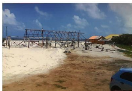
1. Barraca que foi destruída pela força do mar, era a casa do seu Antônio. Na imagem ele está construindo novamente.
