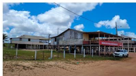
3. A barraca que estava em construção fica é a primeira casa da comunidade da Ponta da Sofia.
