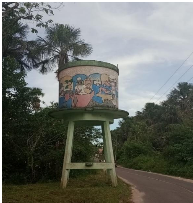
Figura 15 - Caixa d'água de abastecimento do trem (atualmente).
