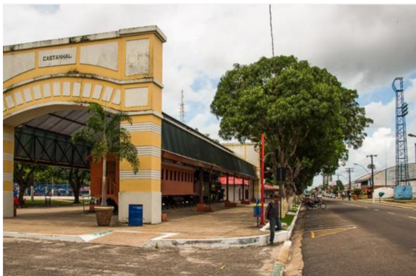
Figura 4 - Reconstituição da Estação de Castanhal, demolida em 1972.
