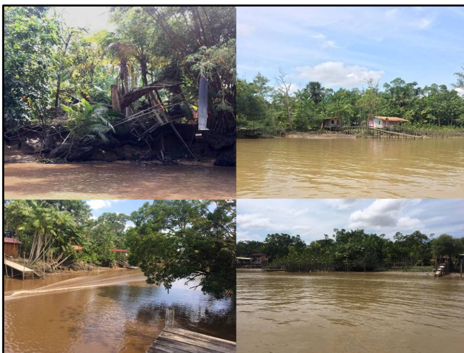
Figura 6- Intensificação da erosão nas margens dos rios no igarapé Combú. Fonte: Autora.
