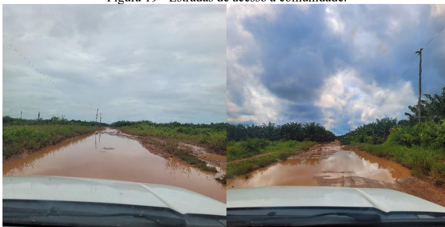
Figura 19 - Estradas de acesso à comunidade.
