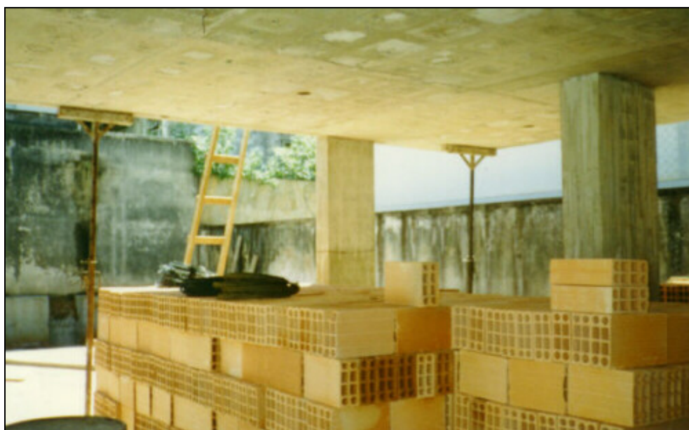
Figura 1.1 – Laje lisa de concreto armado
