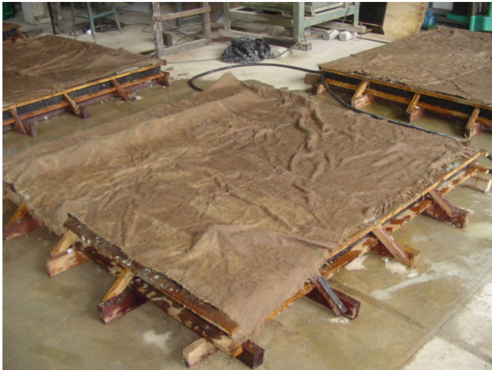
Figura 3.28 – Cura das lajes
