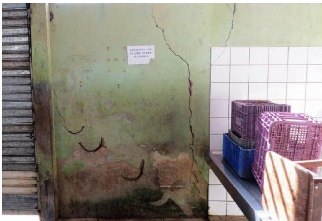
Figura 16: Nas paredes, as trincas alcançam 2 m de altura e 1 cm de espessura, aproximadamente.
