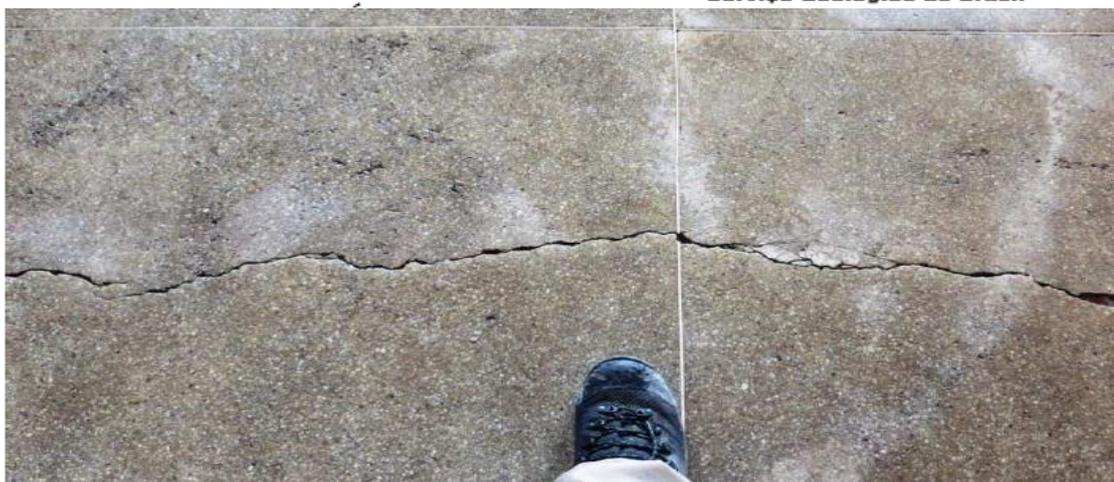
Figura 15: As trincas são paralelas a Av. Quinze de Agosto e apresentam aproximadamente 3 m de comprimento e 1 a 4 cm de espessura.
