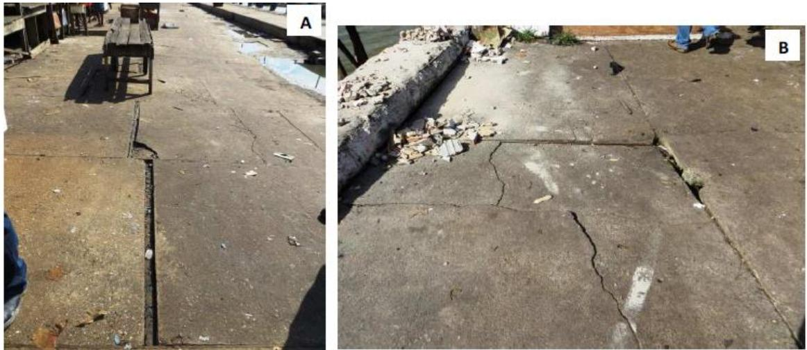
Figura 18: (A) Deslocamento e recalque dos blocos que compõem o chão da feira.
