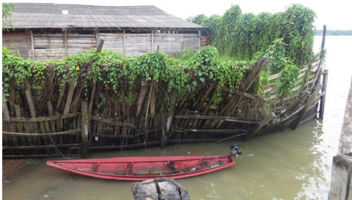
Figura 8: Talude artificial contido por madeira.
