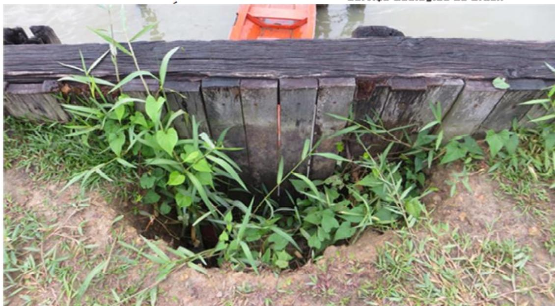
Figura 13: Erosão no aterro é caminho preferencial para o escoamento superficial.
