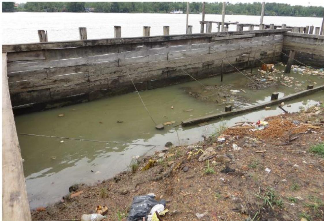
Figura 11: Exemplo típico de construção de um talude artificial ao longo da orla de Abaetetuba.
