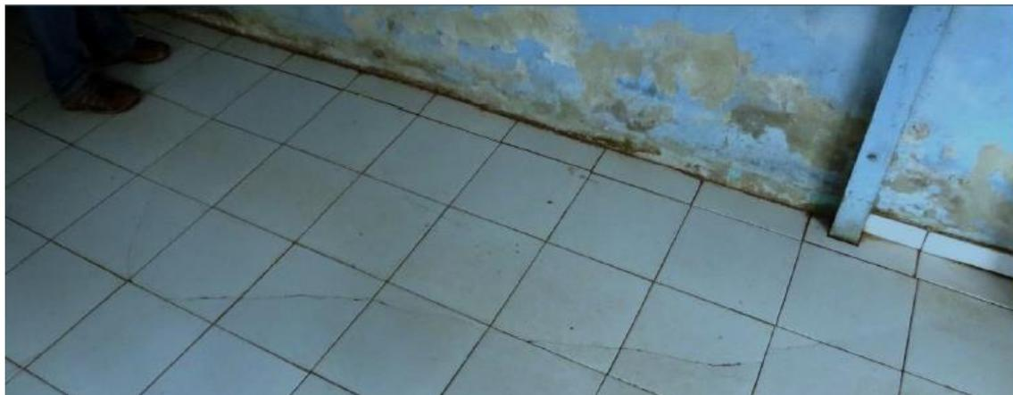
Figura 5: Ocorrência de trinca no piso da residência.
