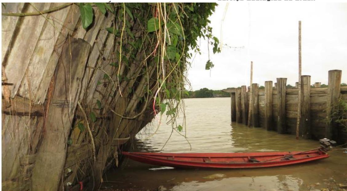
Figura 9: Obra de contenção de madeira em processo de tombamento.
