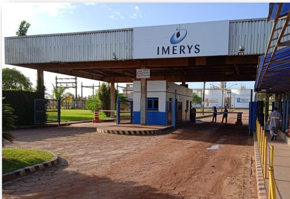
Figura 6 – Portão de entrada da empresa IRCC
