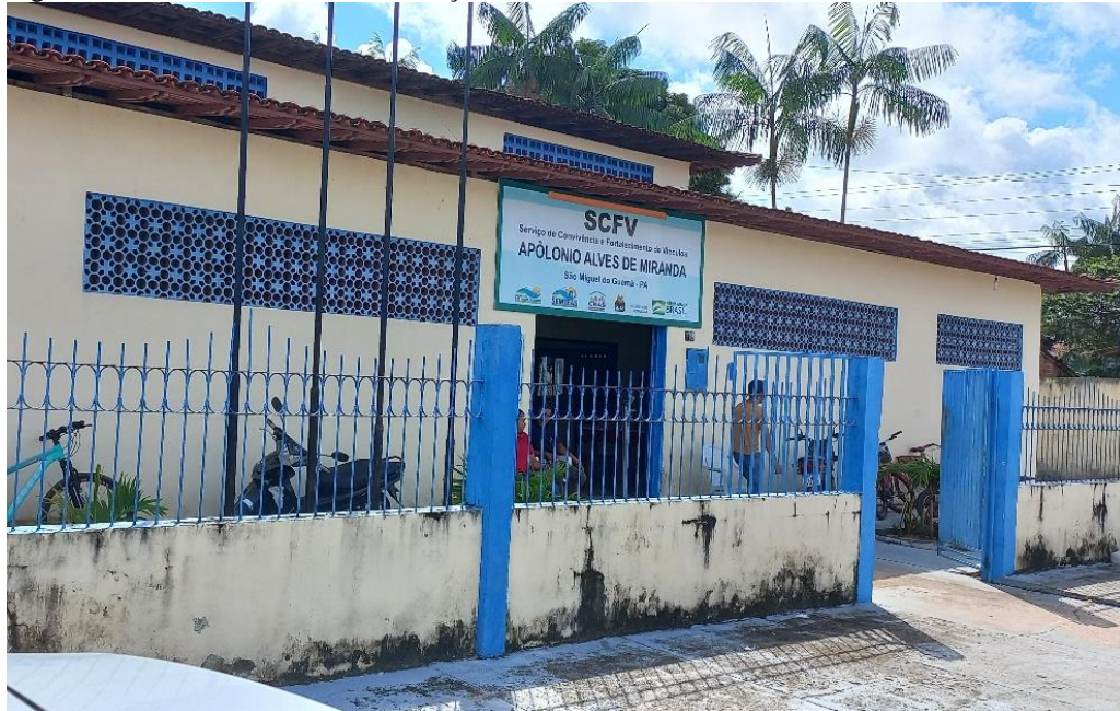
Figura 8- Faixada da entrada do Serviço de Convivência e Fortalecimento de Vínculos
