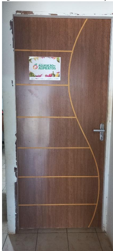
Figura 6 – Porta de acesso à coordenação do PAA
