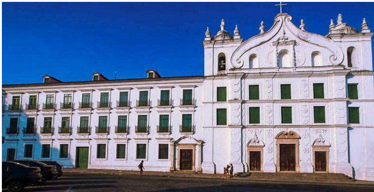
Figura 26: Fachada da Igreja de Santo Alexandre e ao lado o Palácio Episcopal, onde atualmente se abriga o Museu de Arte Sacra do Pará. Fonte: Antônio Athayde.
