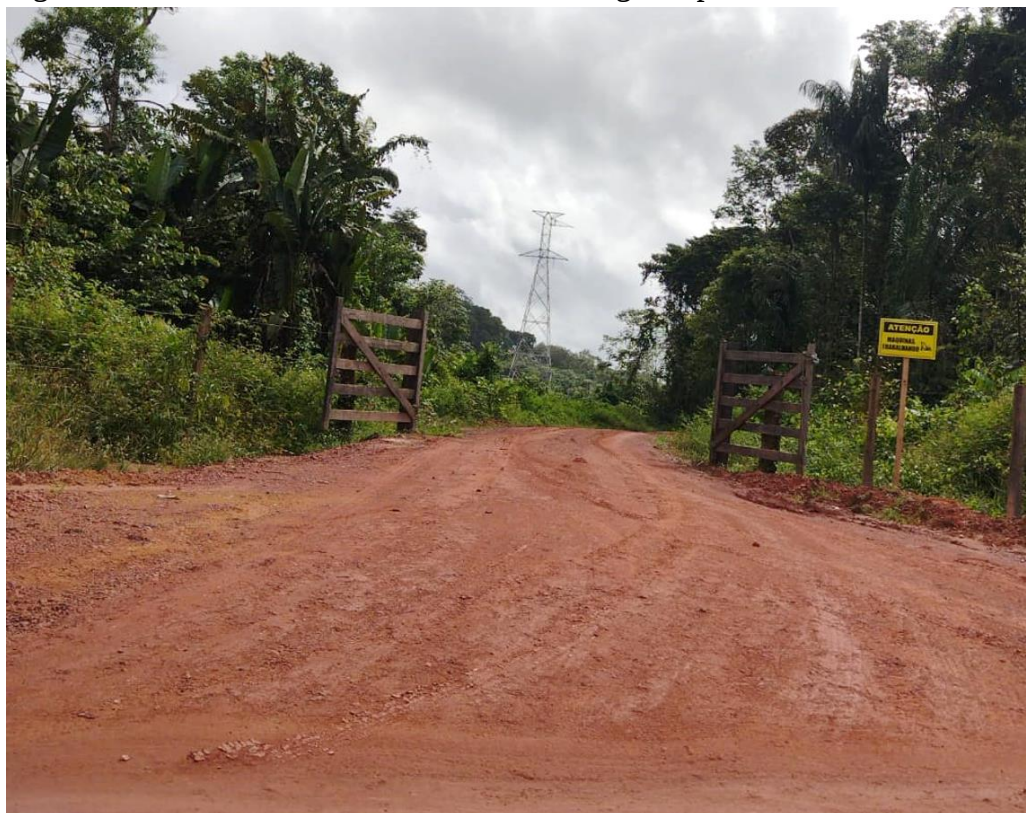
Figura 21 – Via de acesso aberta e torre de energia implantada
