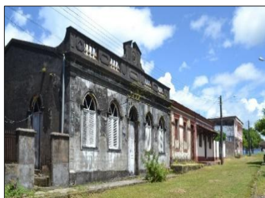
Figura 31: Prédios antigos no bairro da Campina, referentes ao período em que o espaço maracanaense ainda se denominava Cintra (Pereira, 2007)
