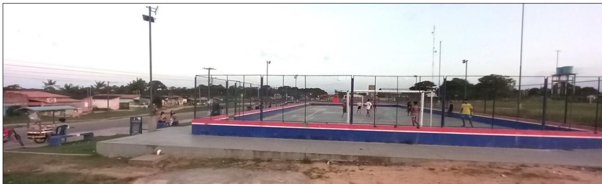
Figura 62 – Quadra de esportes construída às margens da PA-127, próximo aos conjuntos habitacionais Tinolândia e Vovô Índio, em Maracanã/PA
