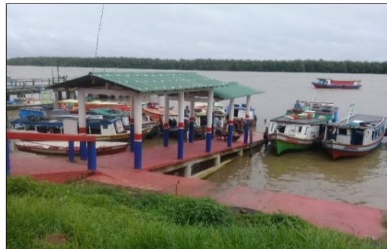
Figura 19: Novo trapiche público no porto principal de Maracanã/PA
