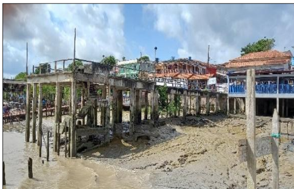
Figura 20: Trapiche/Ponte de concreto armado construída após 1960 na frente da cidade de Maracanã/PA
