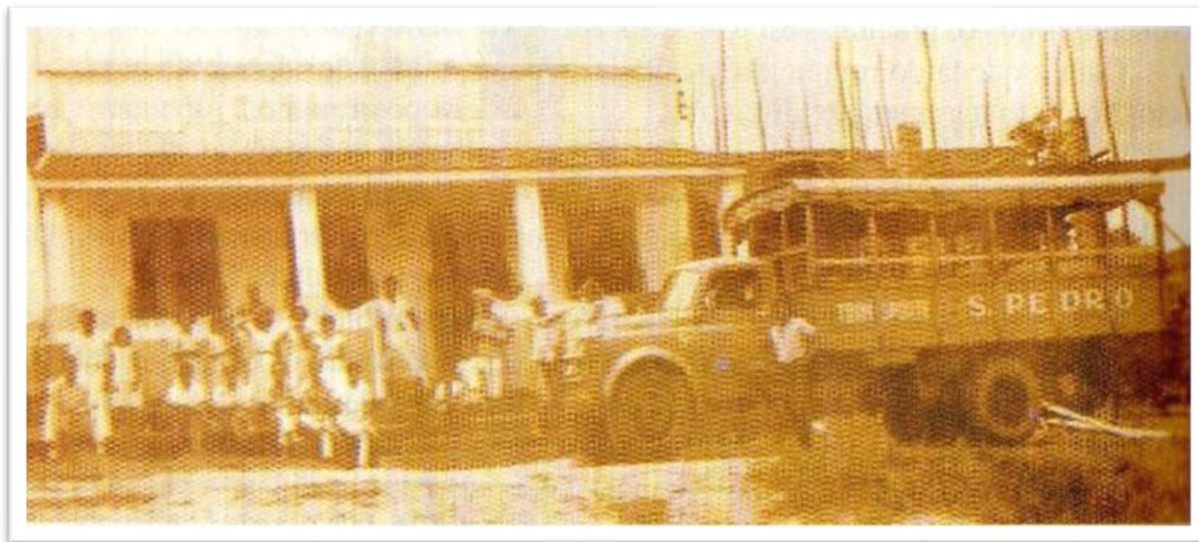
Figura 2: Casa São Pedro em construção, 1956. No detalhe, caminhão pau-de-arara que fazia o transporte de passageiros e cargas para Belém/PA
