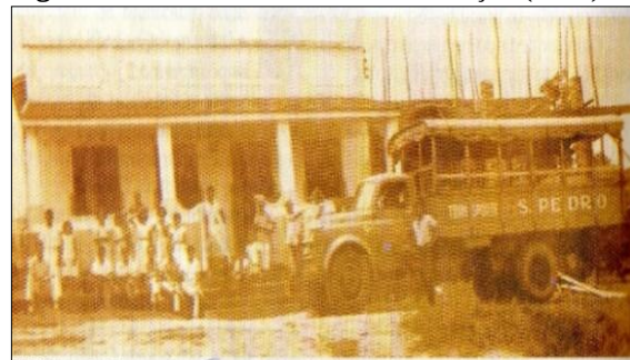
Figura 35: Casa São Pedro em construção (1956).
