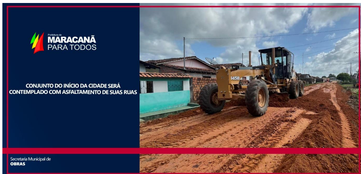
Figura 60: Serviço de pavimentação nas ruas do conjunto Tinolândia e Vovô Índio, bairro Liberdade, Maracanã/PA
