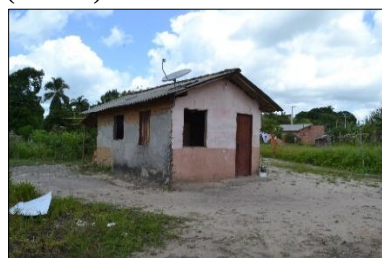
Figura 52: Casas de pau-a-pique cobertas com telhas de fibrocimento (Brasilit) e com antena instalada
