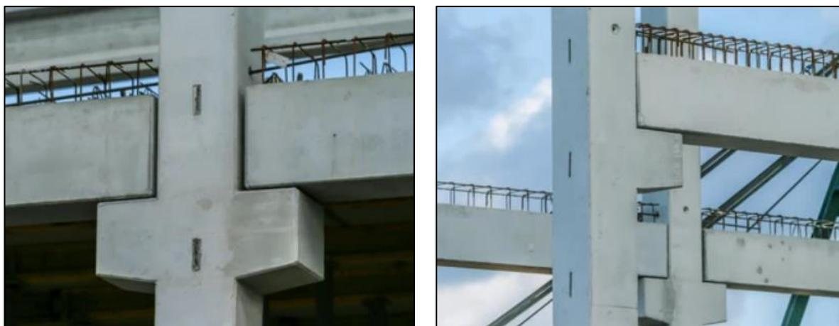
Figura 2.1 - Utilização de consolos de concreto armado (Bobek *et al.*, 2024).
