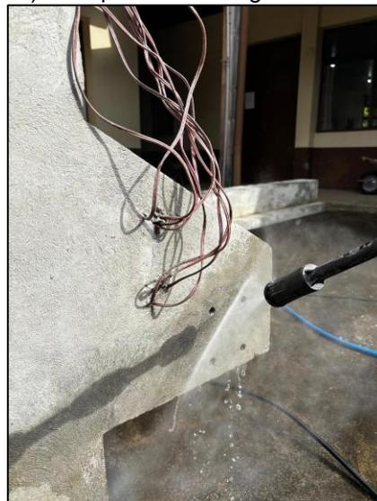
d) Lavagem da superfície e furos da ancoragem híbrida
