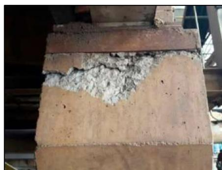
b) Ruptura localizada devido à posição inadequada do apoio
