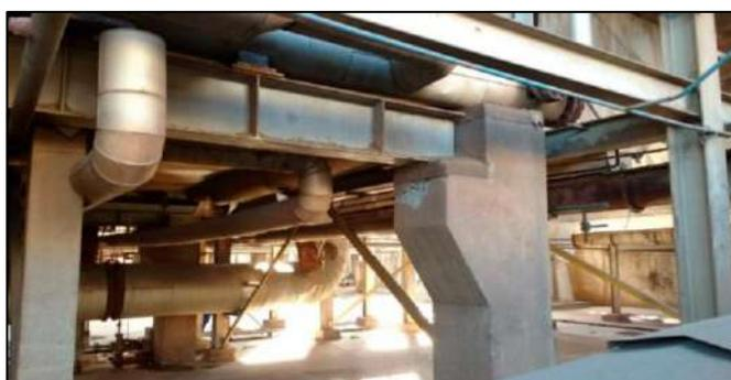
a) Consolo de concreto armado projetado para suportar viga metálica de perfil W enrijecido
