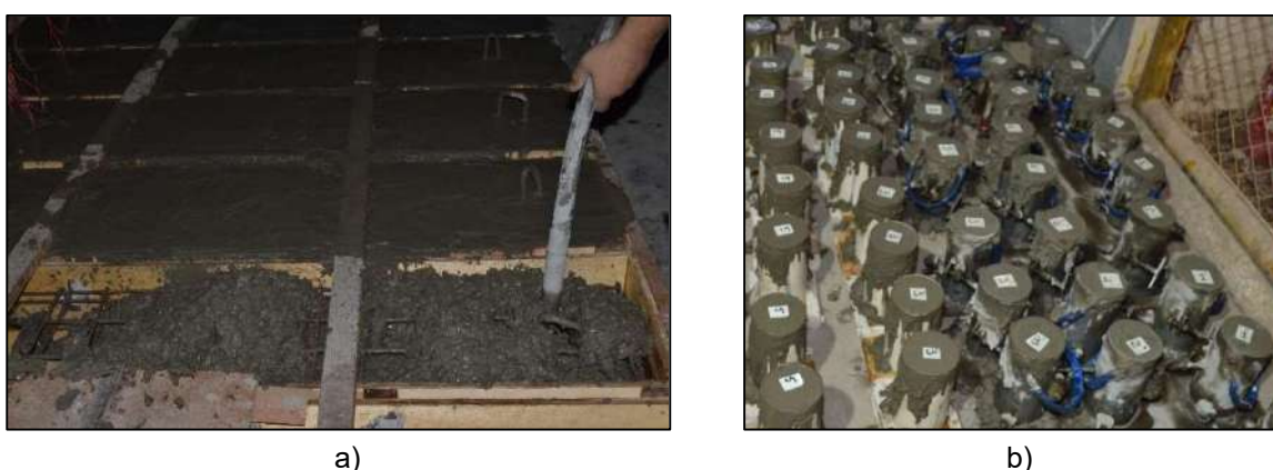
Figura 3.9 - Concretagem. a) Adensamento das vigas; b) Moldagem dos corpos de prova.
