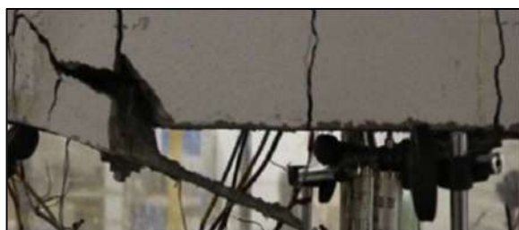
a) Falha na ancoragem
