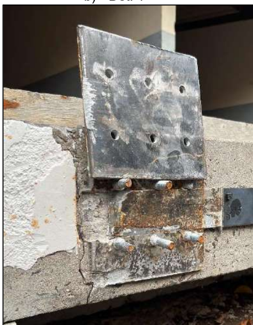
e) Superfície chapa/laminao/concreto
