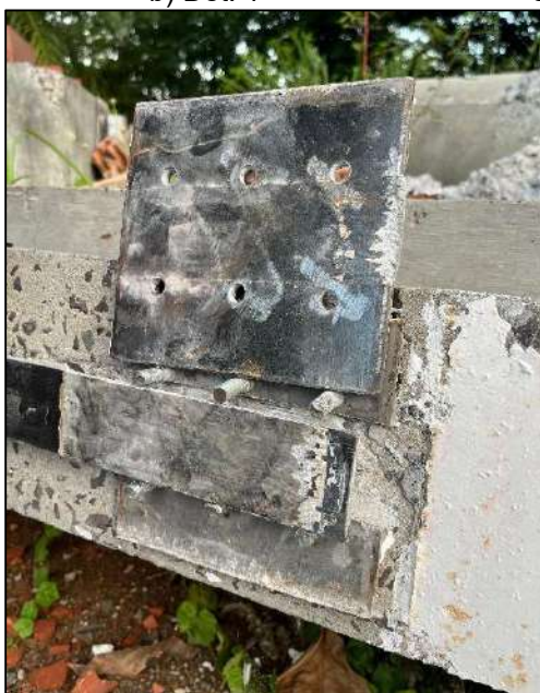
e) Superfície chapa/laminao/concreto
