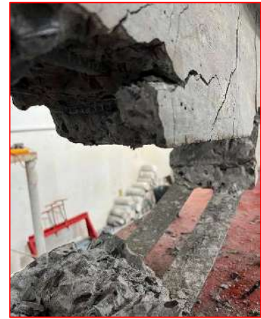
c) Det. 2 – Delaminação CC e destacamento do concreto
