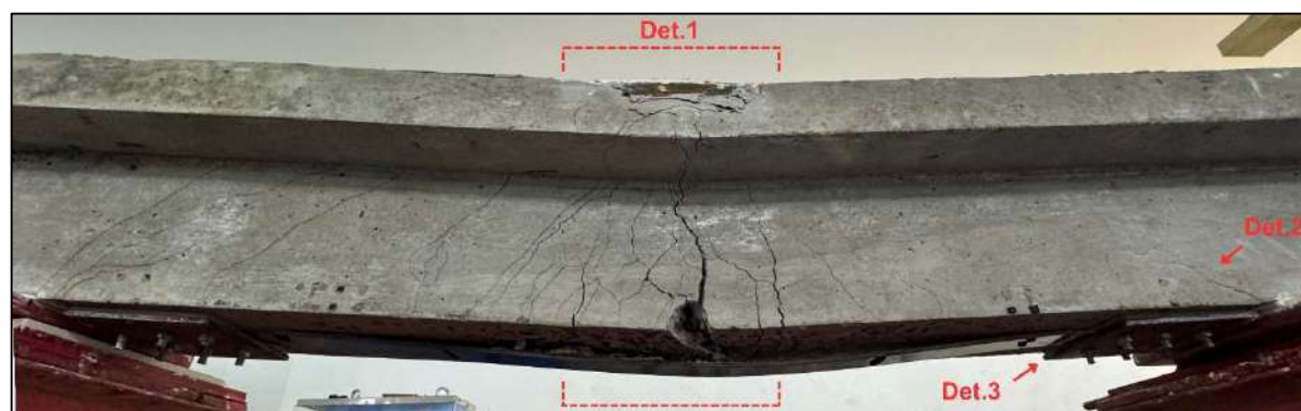
a) Viga HB-1,16
