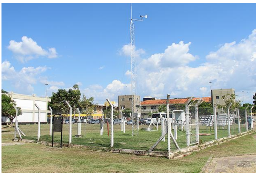
Figura 17 – Estação meteorológica do Instituto de Geociências da Universidade Federal do Pará. Fonte: (Ufpa 2017).
