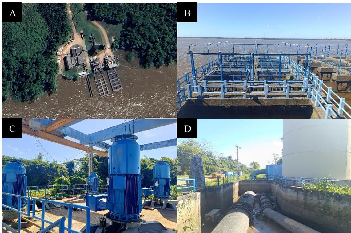
Figura 4 – Sistema de adução utilizado para a captação de água do rio Guamá com destino ao lago Água Preta. (A) Imagem de satélite mostrando a visão aérea do ponto de captação; (B) Estrutura de gradeamento, onde ocorre a entrada da água e a retenção de materiais sólidos de maior porte; (C) Conjunto de quatro das oito bombas responsáveis pela captação mecânica da água; (D) Tubulações que conduzem a água bombeada em direção ao lago Água Preta.
