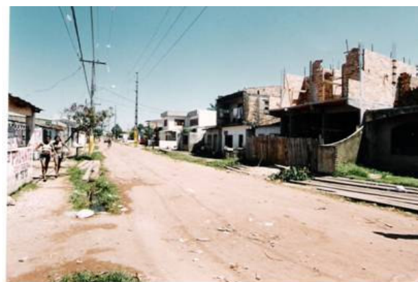
Foto 2: Rua aterrada após a macrodrenagem
