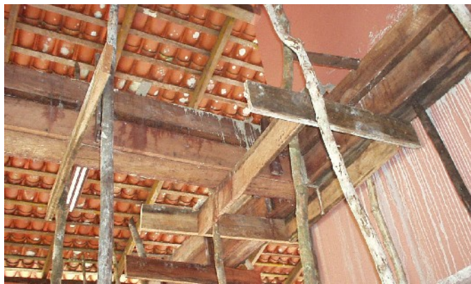
Figura 6 – Fôrmas e escoras.
