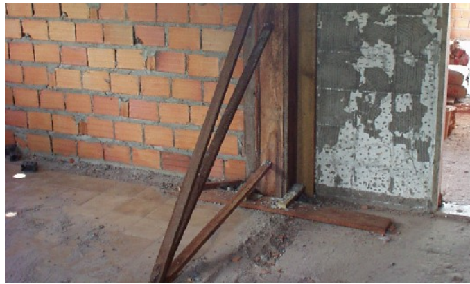
Figura 5 – Fôrma de concreto
