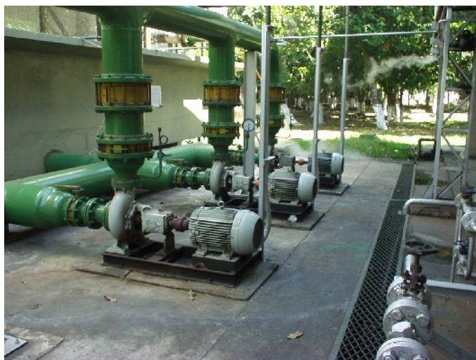
Figura 3 – Usina termoeletrica (turbinas) – Belém – Pará
