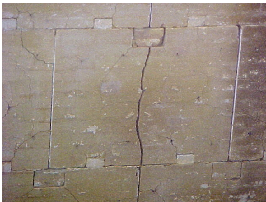
FIGURA 3.11 – Camada referente aos blocos de concreto isolante
