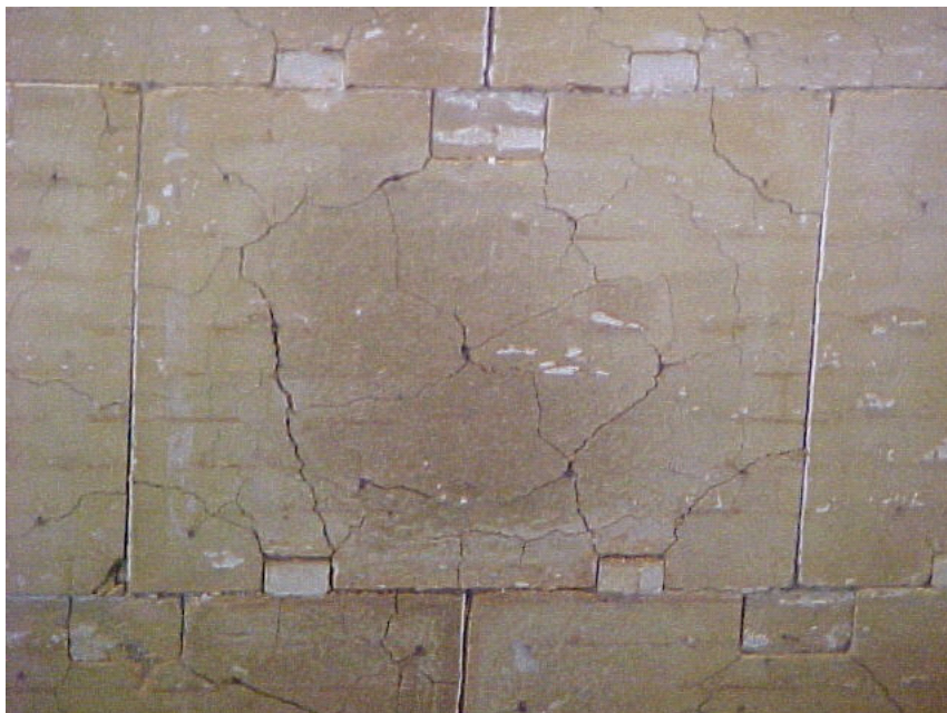
FIGURA 3.10 – Camada referente aos blocos de concreto isolante
