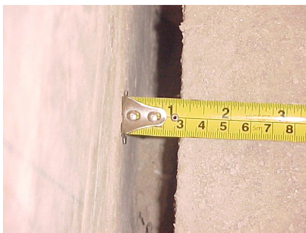
FIGURA 5.3 – Detalhe da junta de dilatação
