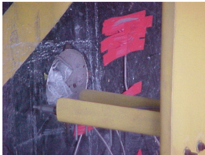
FIGURA 4.9 – Detalhe do sensor de deslocamento linear e do sensor de temperatura
