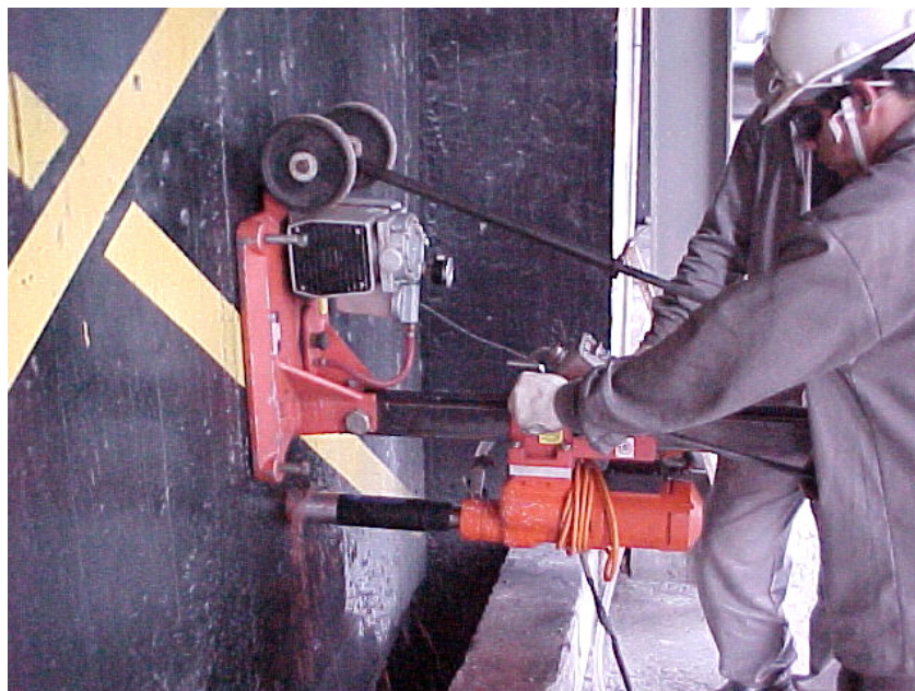
FIGURA 3.14 – Processo de retirada do testemunho para medição da condutividade térmica
