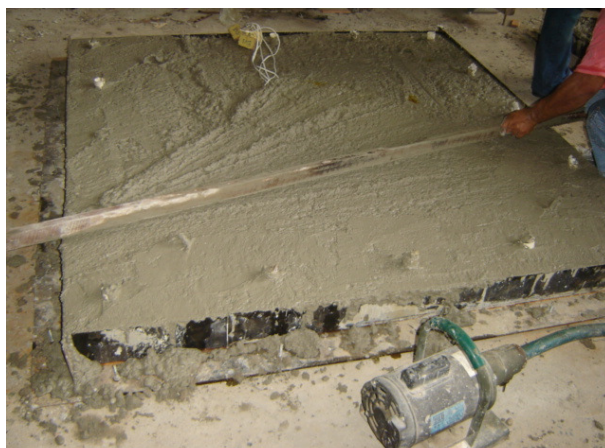
Figura 69 - Adensamento e regularização da superfície de concreto
