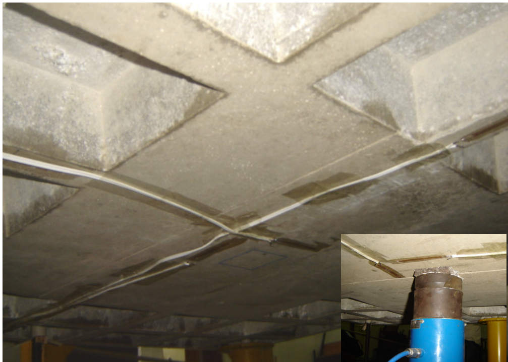
Figura 54 - Detalhe dos extensômetros fixados na laje
