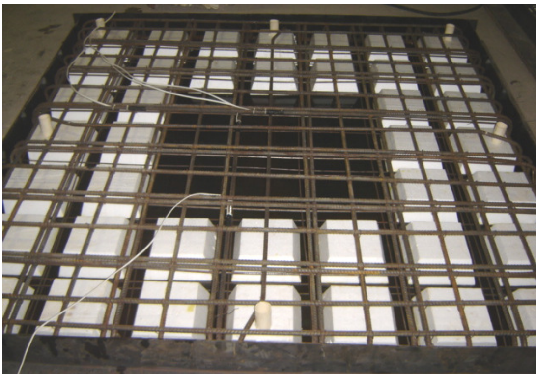
Figura 58 - Monitoramento da armadura de flexão da laje L1
