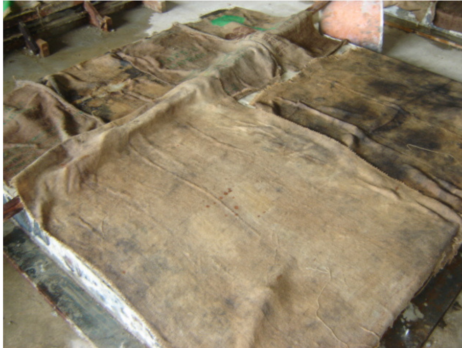
Figura 71 - Cura das lajes e dos corpos de prova utilizando sacos de aniagem
