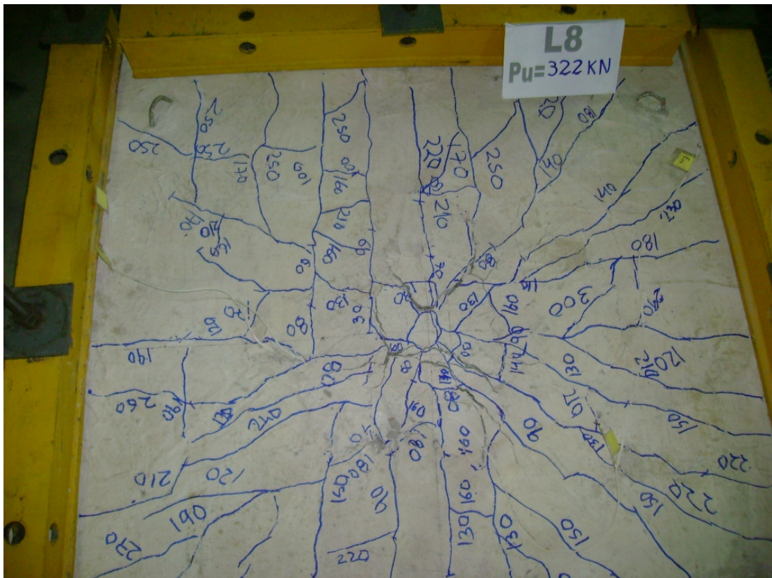
Figura 137 - Padrão de fissuração da laje L8
