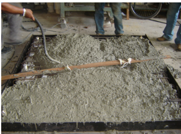
Figura 69 - Adensamento e regularização da superfície de concreto
