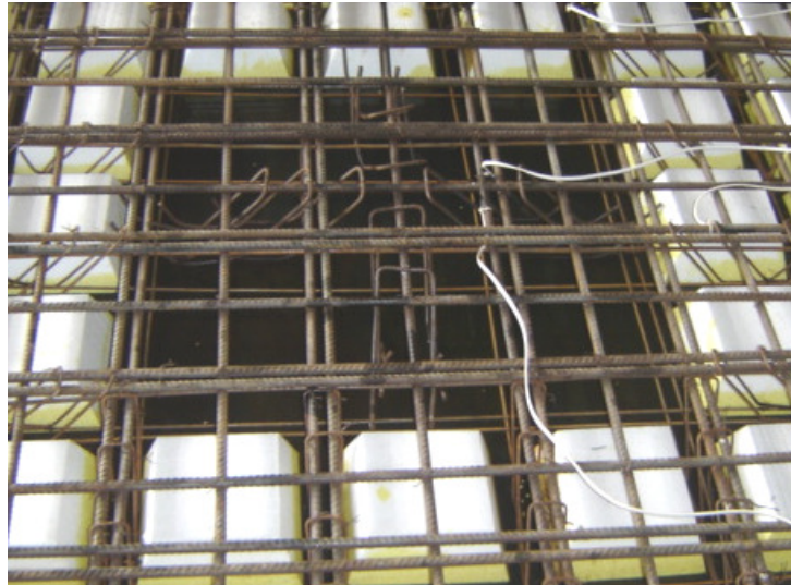
Figura 43 - Estribos posicionados na região maciça da laje L8
