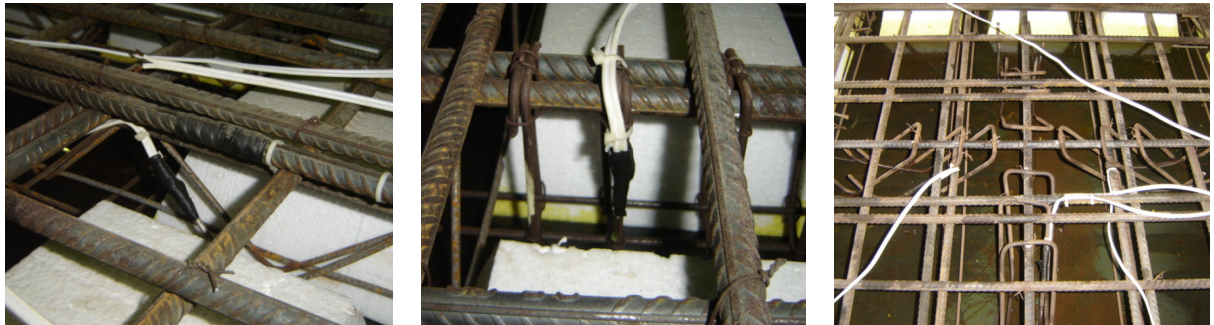
Figura 62 - Detalhe do monitoramento das armaduras de cisalhamento
