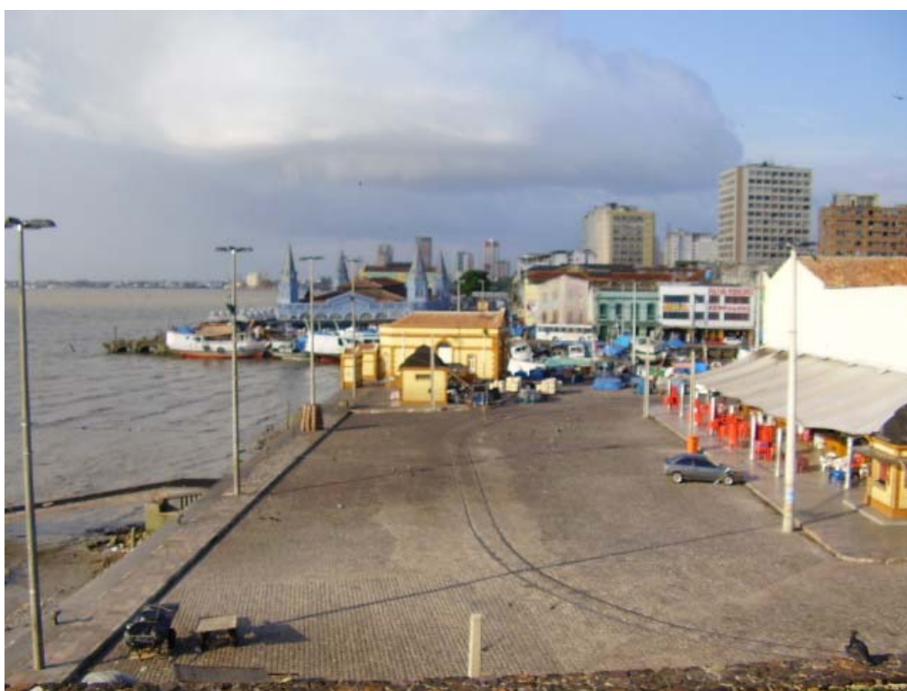
Foto 17: Barracas de Alvenaria e Cobertas com o Sistema de “Tendas” Tencionadas na Feira do Açaí.
