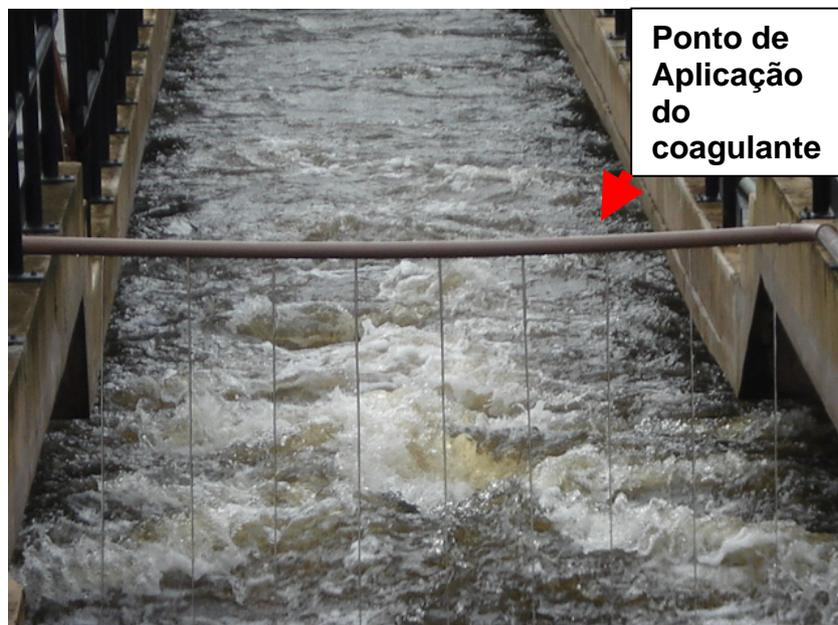
**Figura 4.15:** Ponto de aplicação do Cloreto de Polialumínio e a calha Parshall na ETA Bolonha.
