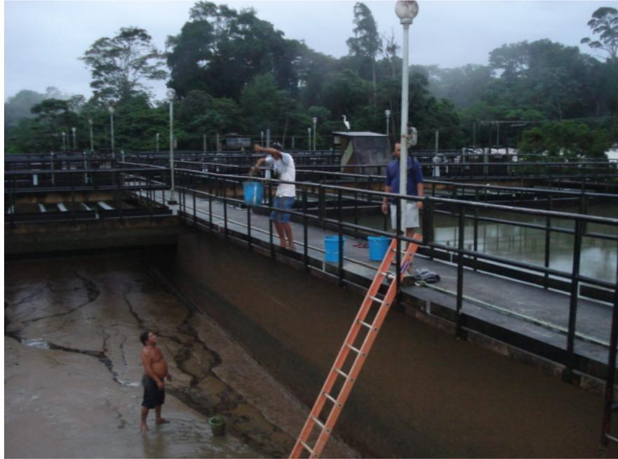
**Figura 4.25:** coleta manual de lodo no fundo do decantador nº 04.
