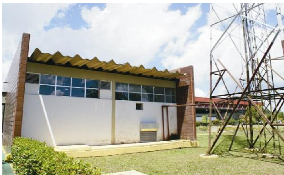
Figura 6.7 - Sala de comunicação onde será instalado o computador para recebimento dos dados.
