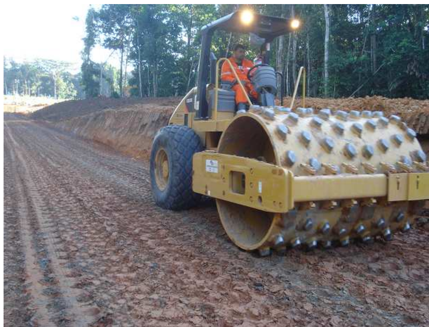
Preparação da pista de rolamento
