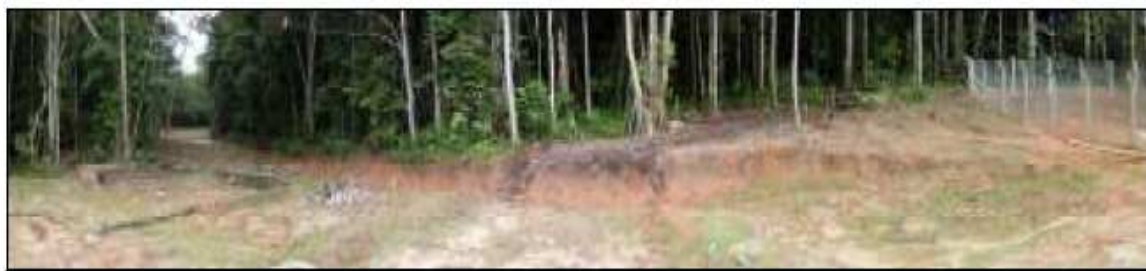
Figura 2.9: Terraço em corte no acesso existente próximo a chegada da ECOMP, expondo solos argilo-arenosos (Andrade 2009).
