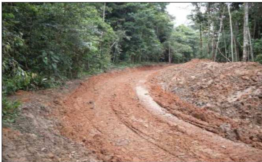
Figura 2.11: Vista de parte de um trecho do acesso existente.
