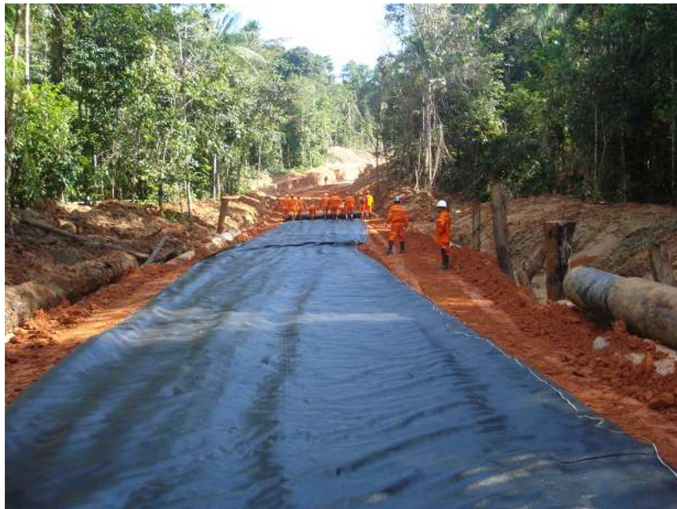
Utilização de mantas de reforço geotecnológico no Acesso Terrestre
