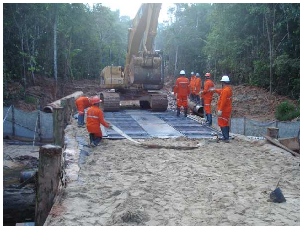
Distribuição de chapas de 1" x 4m x 2.55m para distribuição de cargas uniforme obre a Ponte do Igarapé do Cedro.
