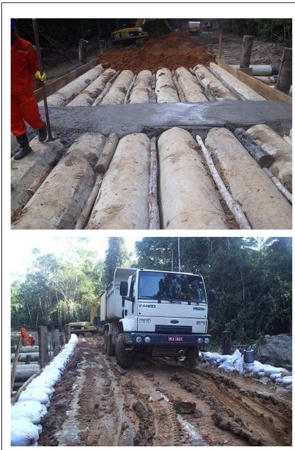
Finalização da Ponte sobre o Igarapé do Cedro
