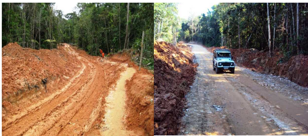
Trecho do acesso
