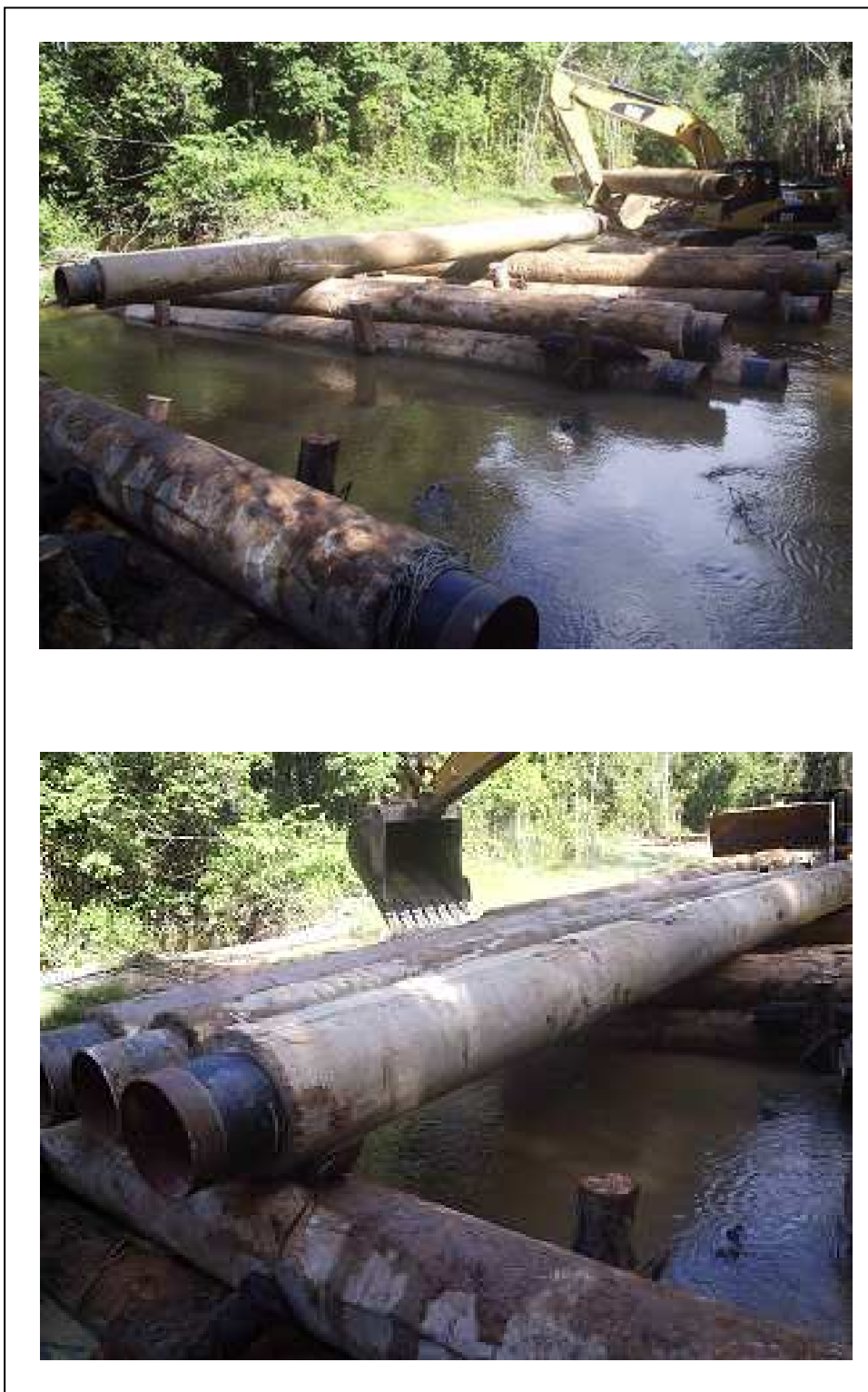
Montagem da Ponte sobre o Igarapé do Cedro
