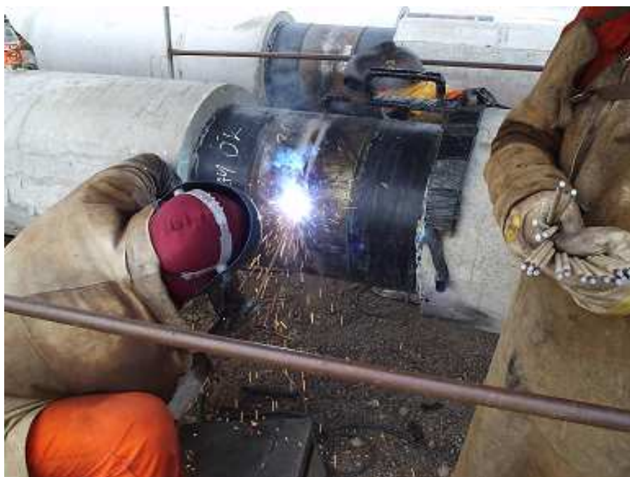
Figura 3.1: Gasoduto Coari-Manaus trecho B2 em Manacapuru
