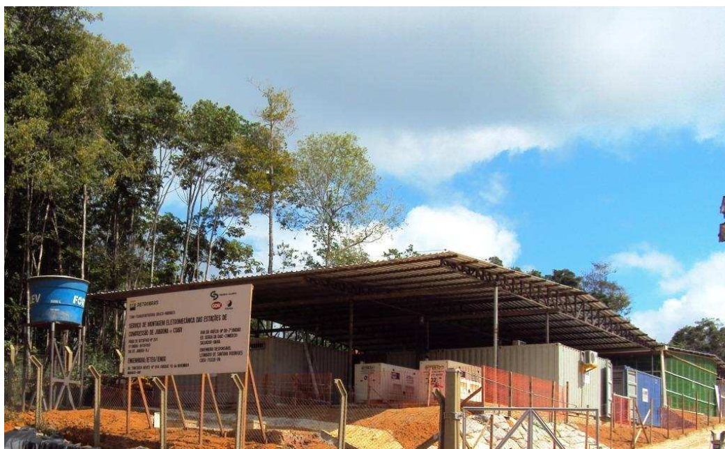
Canteiro de obra do Consorcio Solimões S.A
