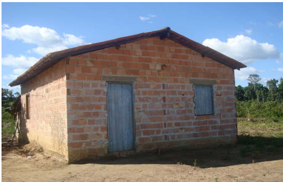
Fotografia 21 - Casa do assentamento não concluída e habitada. Foto: Lucia Andrade, (2009).
