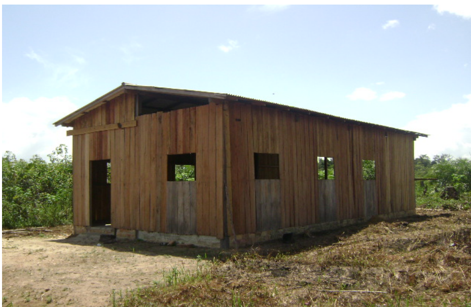
Fotografia 13 – Barracão em construção. Foto: Lucia Andrade, (2009).
