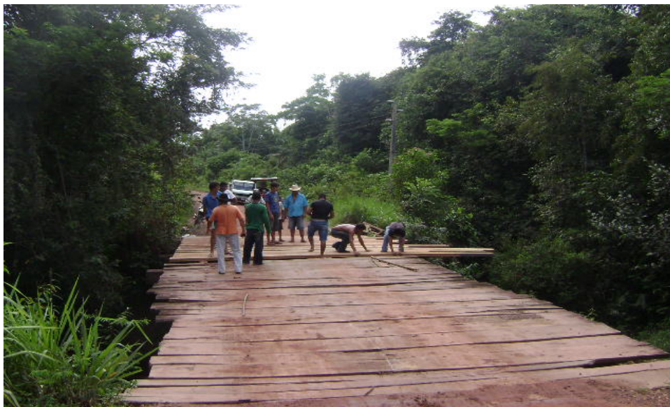
Fotografia 4 - Obras de renovação de ponte na área do assentamento com auxílio dos moradores. Foto: Lucia Andrade, (2009).
