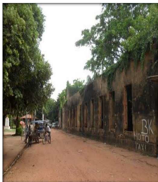
Foto 11: Ruínas da Fachada do Educandário Nogueira de Faria
