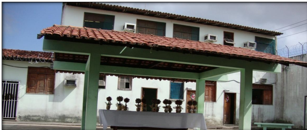
Foto 06: Vista do pavimento superior da Unidade. Registrada em 23/12//2011. (Créditos: Pesquisadora).
